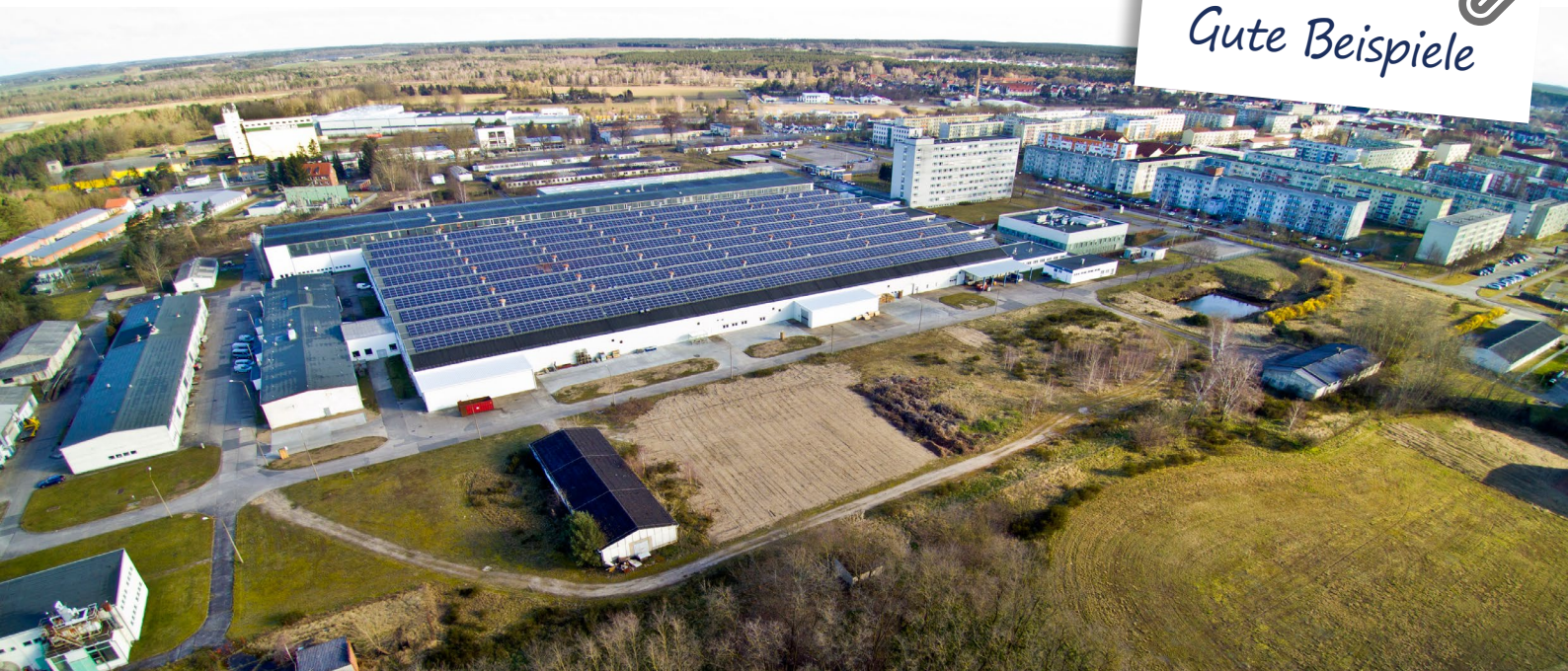
Gewerbegebiet in Parchim (Mecklenburg-Vorpommern) © Ministerium für Wirtschaft, Infrastruktur, Tourismus und Arbeit in Mecklenburg-Vorpommern
